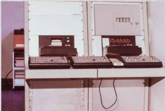
Control Room della Farnesina, Ministero degli Affari Esteri, Roma, 1983
